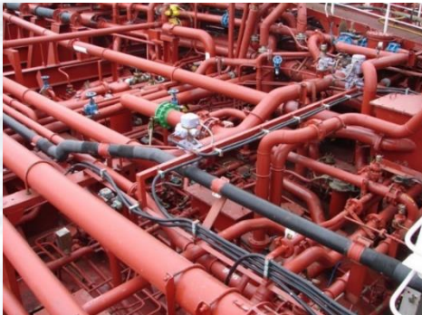
Thử đường ống
